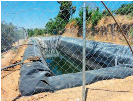
Foto 37. Hoya cubierta por membrana impermeable, plástica preformada. Ubicada en el nivel más alto de la parcela en la terraza 8. Tetela del Volcán, Tetela del Volcán. 2013.
