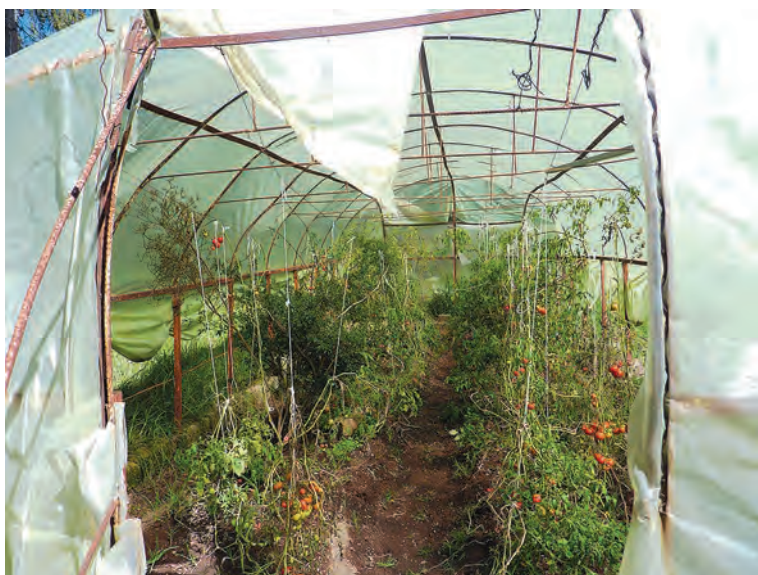
Foto 75. Invernadero de jitomate realizado con varillas. Zautla, Puebla. 2016.
