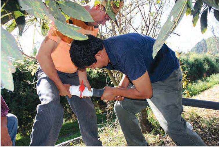
Foto 122. Colocando la válvula de desfogue. Tetela del Volcán, Tetela del Volcán. 2013.
