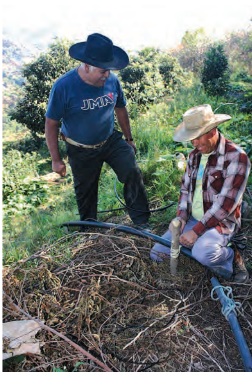
Foto 120. Tendido de la manguera de 2'. Tetela del Volcán, Tetela del Volcán. 2013.
