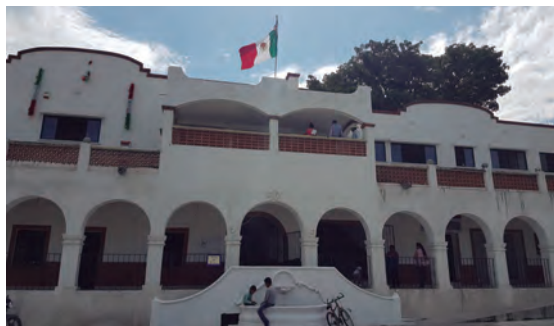
Figura 16. Fachada de la Ayudantía. Foto: Barreto, 2019.
