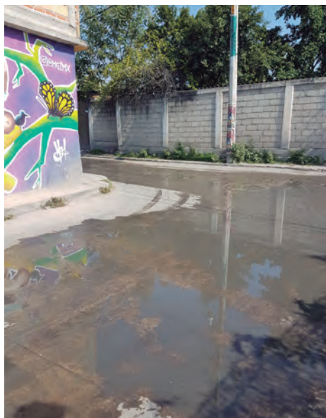
Figura 26. Estancamiento de aguas negras. Foto: Barreto, 2018.
