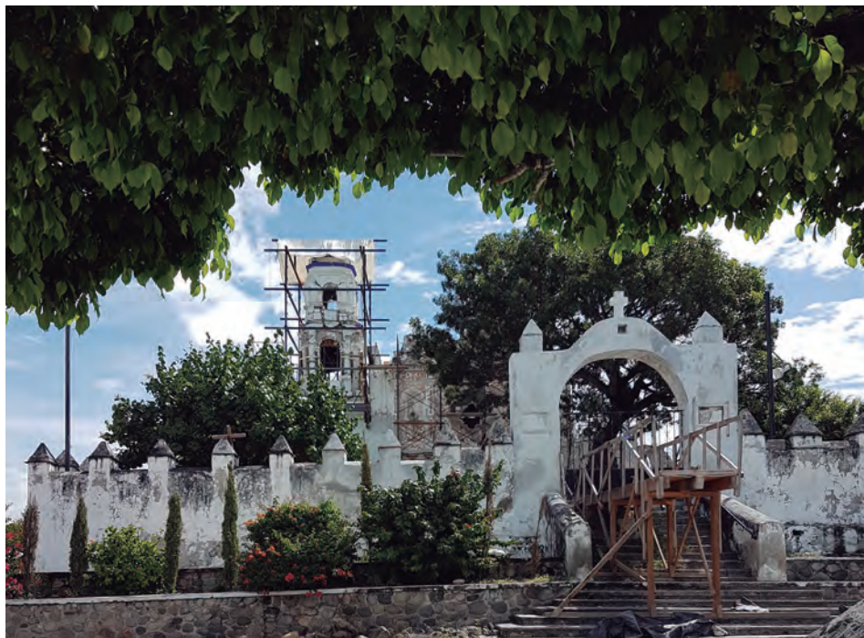
Figura 17. Reparación de la iglesia. Foto: Barreto, 2018.
