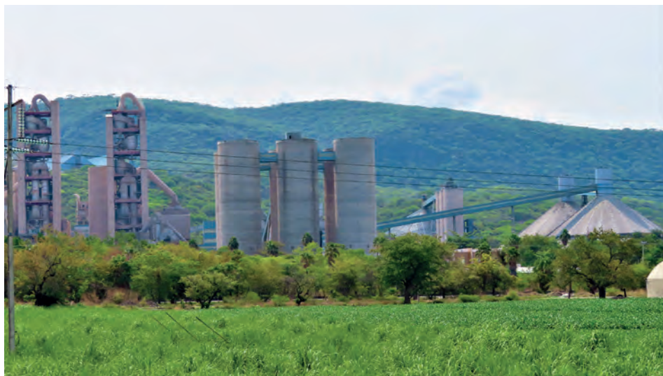
Figura 17. Chimeneas de los hornos de la cementera Moctezuma, Tepetzingo. Foto: González, 2020.
