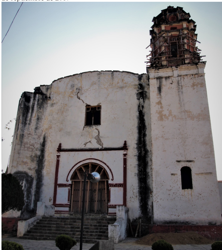
Figura 2. Exconvento de Santo Domingo de Guzmán después del sismo de septiembre de 2017
